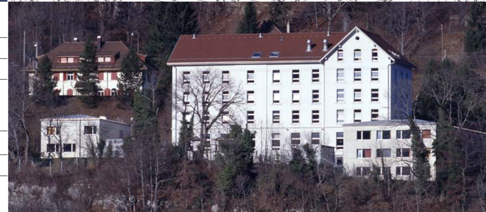
Le bâtiment d'hébergement et les deux bâtiments administratifs
