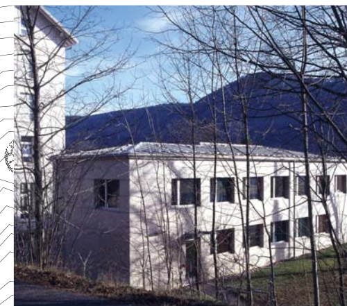
Façade côté forêt de Administration II
