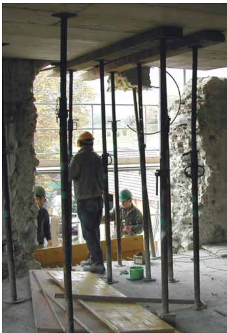
percement des pignons
