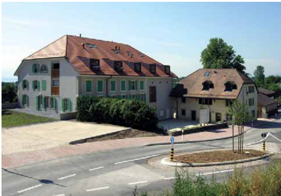
façade Est et cour d'entrée
