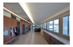
Faux plafonds en fibre pour les classes et en métal ou en alba pour les circulations et services, se conjuguent avec des cloisons revêtues d'ingrain ou de plaques type Duripanel. Les installations techniques reprennent les bases existantes dans les bâtiments des étapes précédentes. Elles se raccordent ainsi aux productions et aux réseaux déjà installés.
